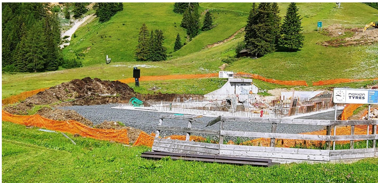
Lavori stazione a valle
