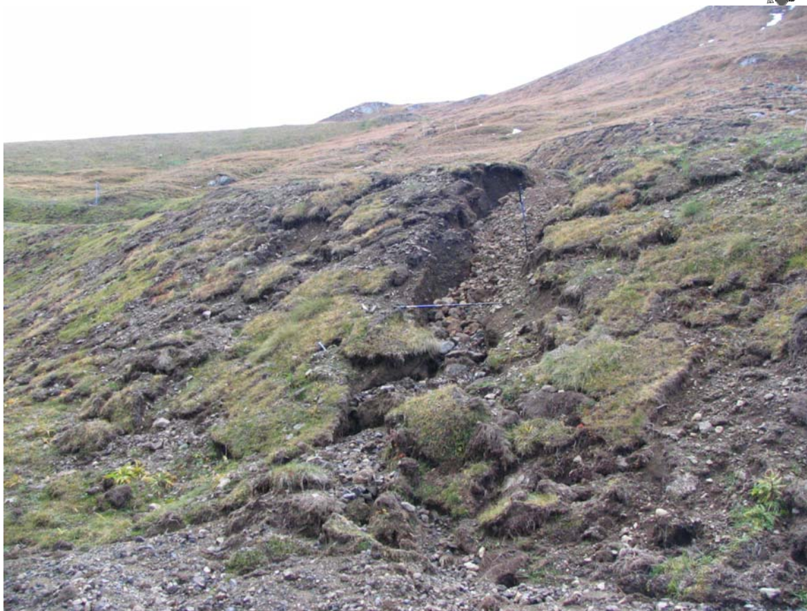
Foto 2.1) 24/9/2005 Pala del Gaigher erosione cedimento zolle
