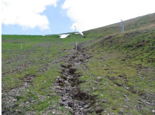
Foto 6.1) 24/9/2005 Particolare foto 6 visione dal basso
