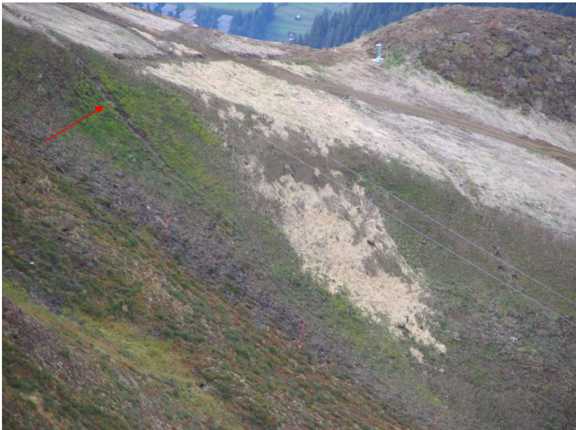
Foto 4) 24/9/2005 stessa colata risistemata, ancora presenti però i fenomeni di ruscellamento a monte
