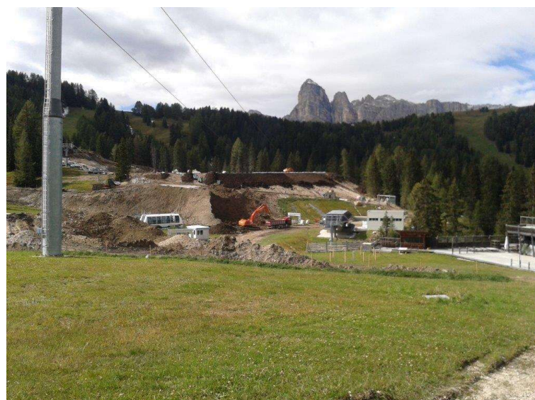
Abbildung 3: Errichtung des Speichers La Brancia 2013
