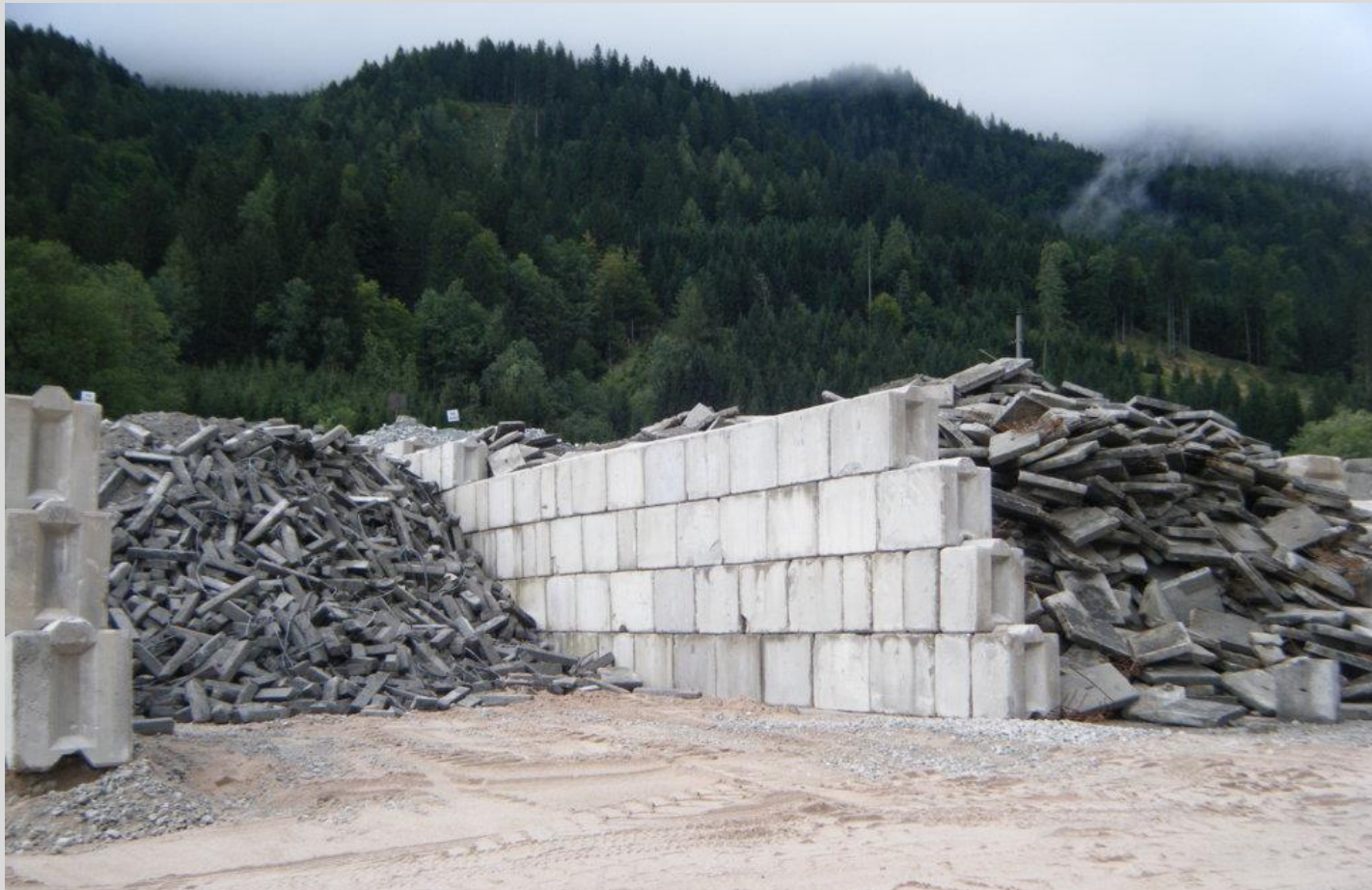
Zwischenlager in der Aufbereitungsanlage des AN Trennung verschiedene Abbruchmaterialien in Boxen
