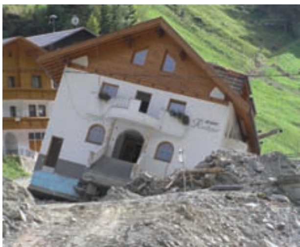
Danni causati dall'alluvione nel Paznaun, settembre 2005: i pericoli naturali minacciano l'esistenza.
