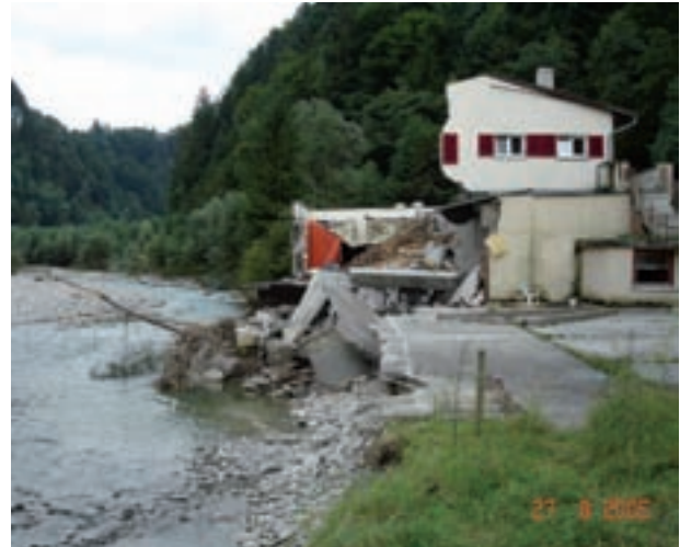
Danni indotti dalla piena del Sense (22.8.2005). In questo caso, l'acqua necessita di più spazio ed occorre spostare gli edifici.
