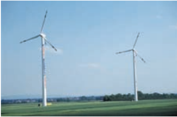
Impianto a energia eolica: lo sfruttamento di energie rinnovabili non genera gas serra dannosi per il clima.
