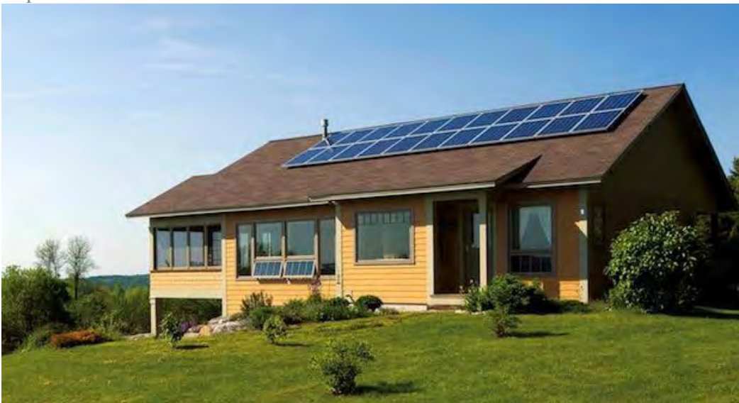
Impianto fotovoltaico domestico
