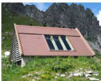
Abbildung 67: Überdachtes Trockenbeet der Mindelheimer Hütte [Foto F.Schönherr (2005)]
