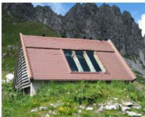
Abbildung 67: Überdachtes Trockenbeet der Mindelheimer Hütte [Foto F.Schönherr (2005)]
