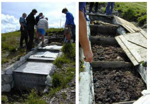
Abbildung 130: Stufenkomposter am Kaiserjochhaus [Fotos R.Ettl (2005)]
