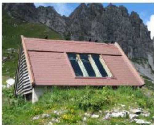
Abbildung 67: Überdachtes Trockenbeet der Mindelheimer Hütte [Foto F.Schönherr (2005)]
