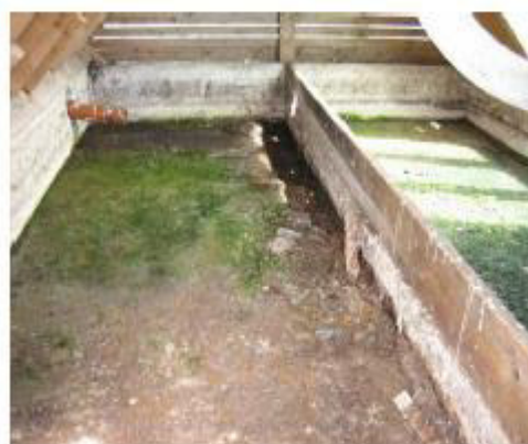
Abbildung 68: Reststoffe zur Behandlung im Trockenbeet [Foto F.Schönherr (2005)]
