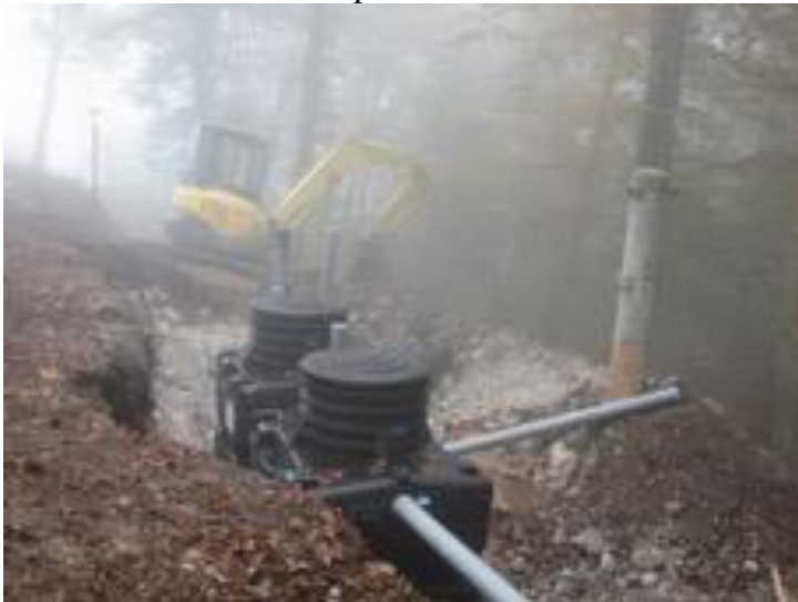
• Figura 18 – Installazione MONOBLOCK
