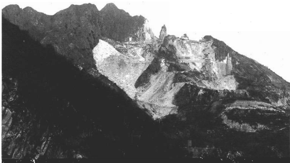
Fig. 2 - Ravaneti attivi e ravaneti in fase di rinaturalizzazione (in basso a destra); si notano anche le profonde alterazioni morfologiche del crinale roccioso, causate dall'escavazione intensiva (Cave di Gioia, bacino del T. Carrione, MS).
