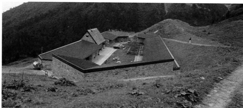
A SINISTRA, UN BELL'ESEMPIO DI RISTRUTTURAZIONE DI UNA MALGA CON LA TRADIZIONALE FORMA A FERRO DI CAVALLO
