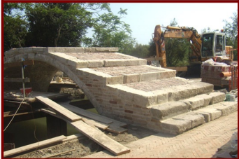
Il Ponte del Diavolo restaurato (luglio 2009)
